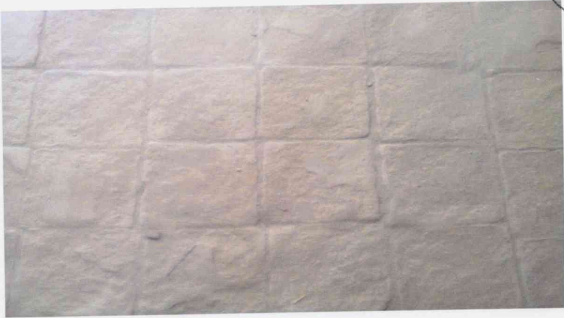
Imagem 01: Pavimentação em tijoleira do pavimento térreo
