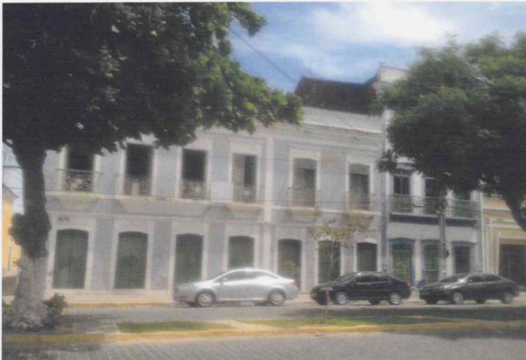
Imagem 04: Fachada principal (Oeste) do edifício.
