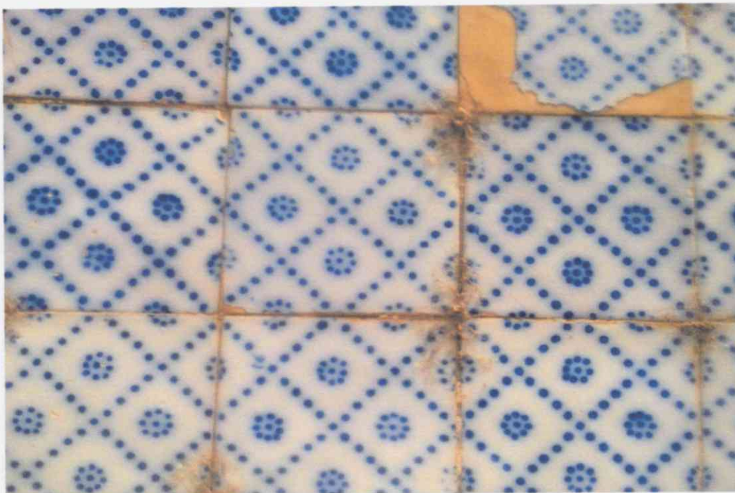
Imagem 05: Revestimento em azulejo da fachada principal e lateral (norte).
