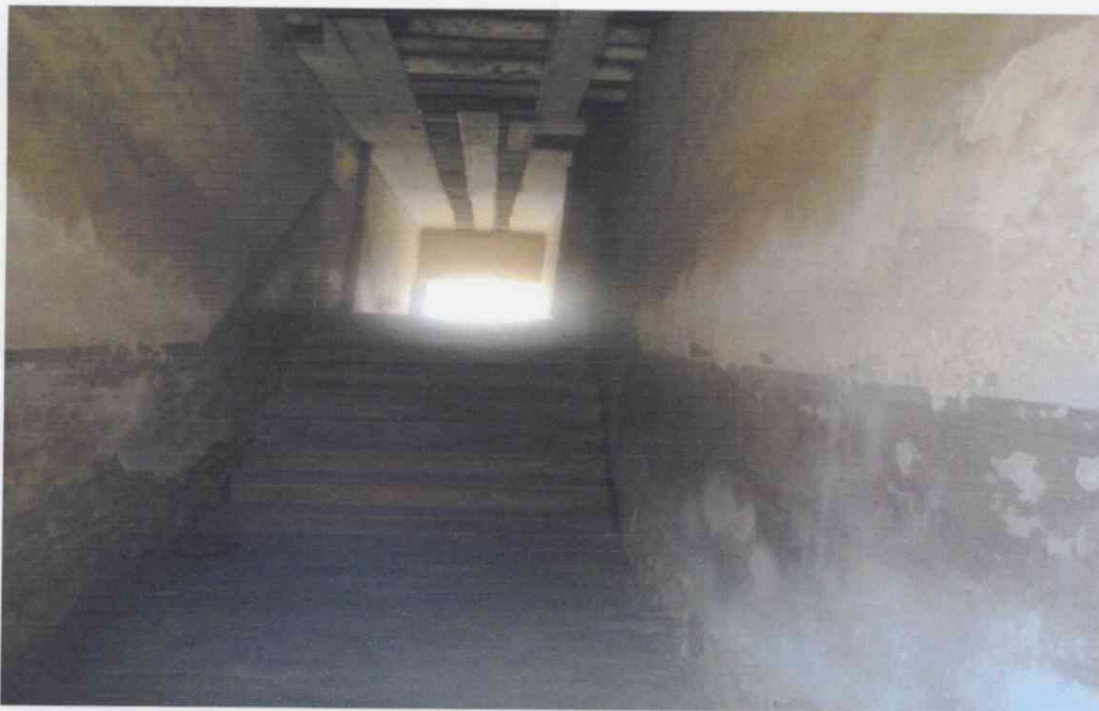
Imagem 07: Vista do vestibulo de acesso, vendo-se a escada que leva ao primeiro pavimento e a estrutura do piso deste (tabuado sobre roletes de carnaúba).
