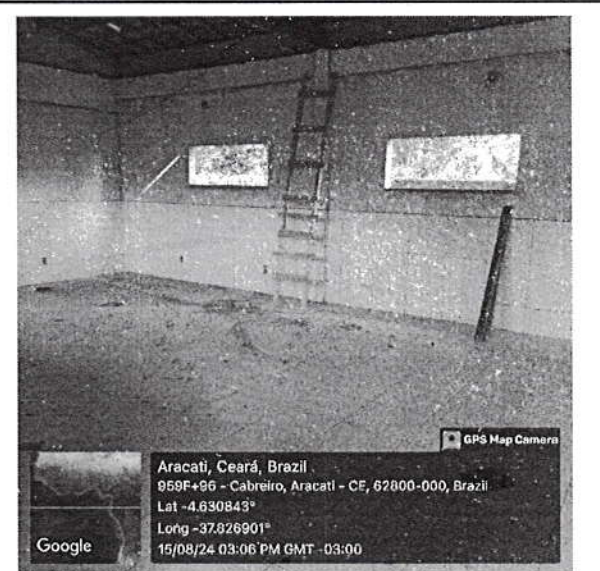
Vista interior das obras remanescentes da escola
