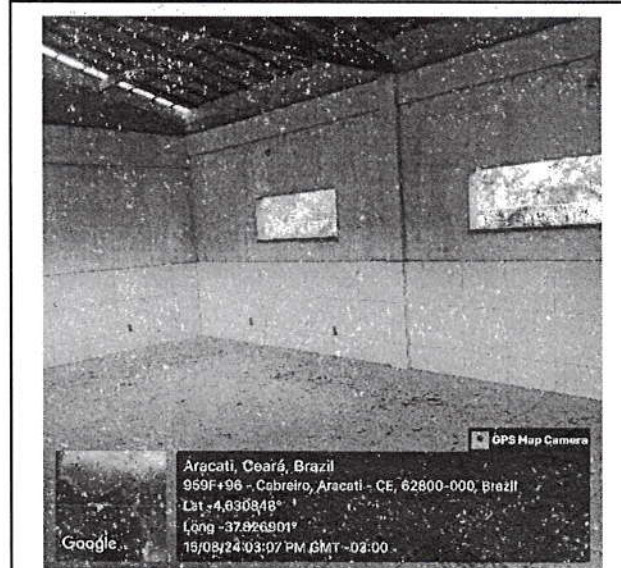
Vista interior das obras remanescentes da escola
