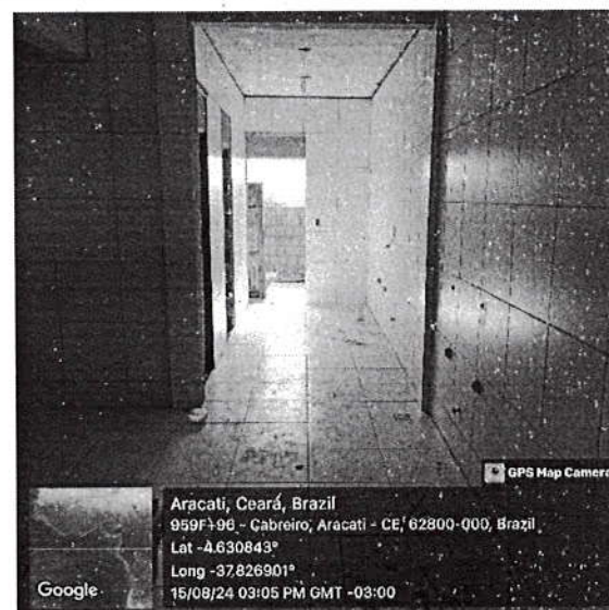
Vista interior das obras remanescentes da escola
