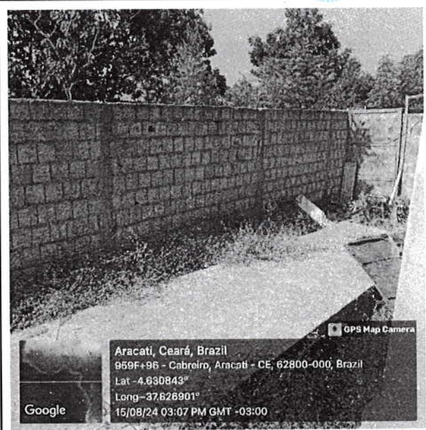
Vista interior das obras remanescentes da escola
