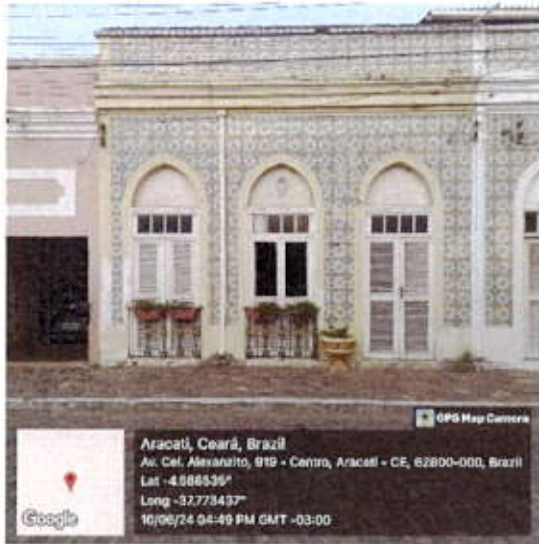
Figura 1 – Fachada principal do imóvel
