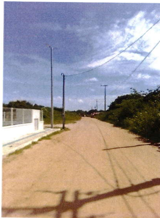
Figura 2 - Imagem da estrada a ser pavimentada na entrada da Comunidade do Outeiro.
