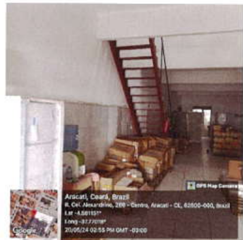
Figura 5 - Escada de acesso ao Pav. Superior
