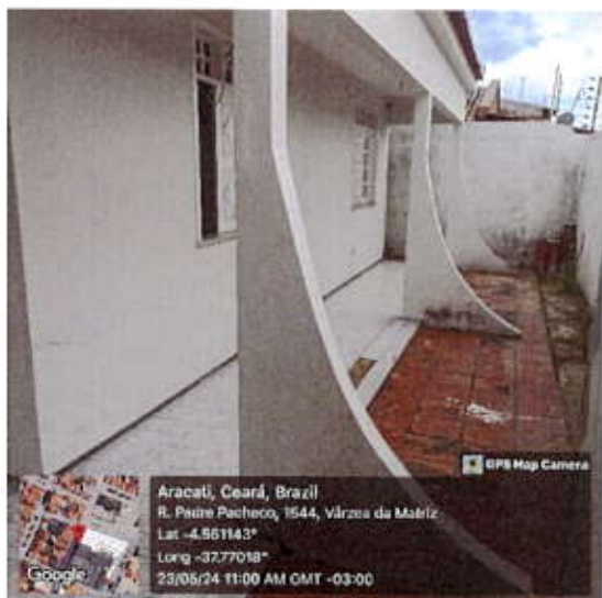
Figura 3 - Área Externa - Fachada Frontal
