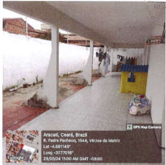
Figura 4 - Área Externa - Fachada Lateral
