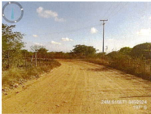
Visão geral da estrada a ser pavimentada
