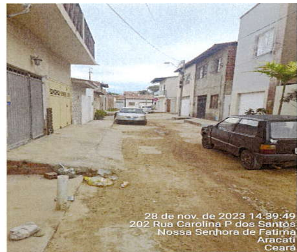
Visão geral da Rua Carolina P Dos Santos
