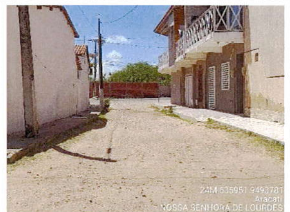
Visão Geral da Travessa Cor. Pompeu
