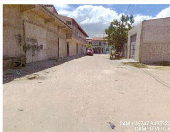
Visão inicial da Rua SDO - Tabelião 02
