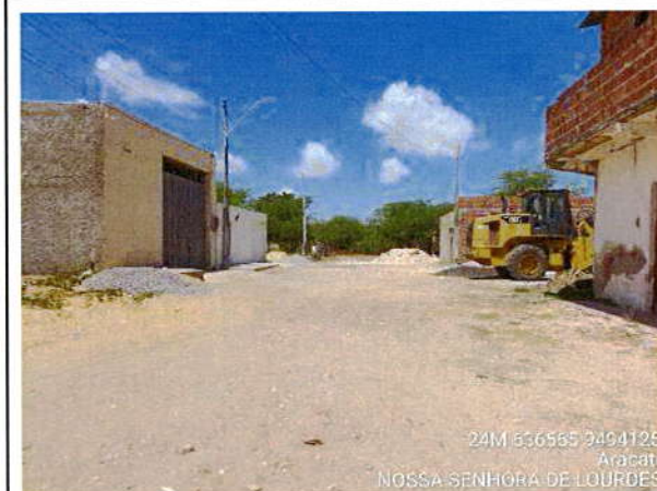
24M 636565 9494125 Aracati NOSSA SENHORA DE LOURDES Visão geral da Rua SDO 03
